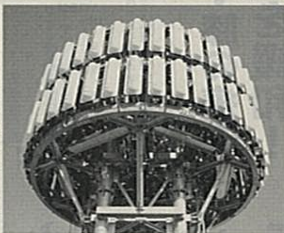
●地デジ用アンテナを取り付けた様。この柱ごとスカイツリーに運ばれ、最上部に取り付けられた●鉄塔へ試験的に取り付けられたアンテナ（いずれも昨年12月6日、茨城県日立市で）
