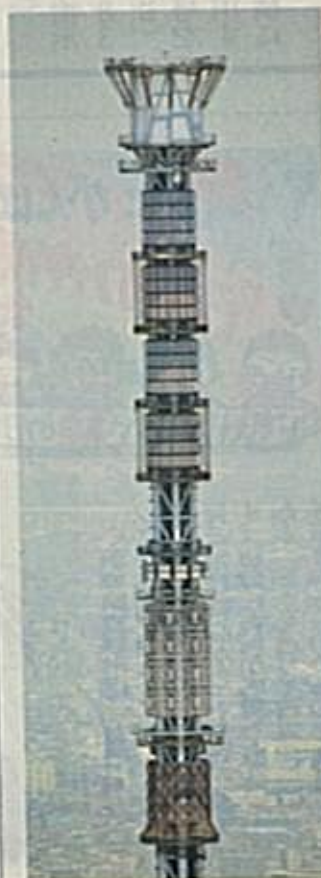
スカイツリーのアンテナ部分。一番上には、地震や風の揺れを抑える白い円筒状の装置が取り付けられている（15日、本社へリから） —清水敏明撮影
