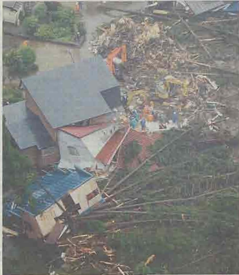
土石流で木と一緒に流された民家周辺で続く捜索作業(9日午後5時27分、秋田県仙北市で、本社ヘリから) 一前田尚紀撮影
