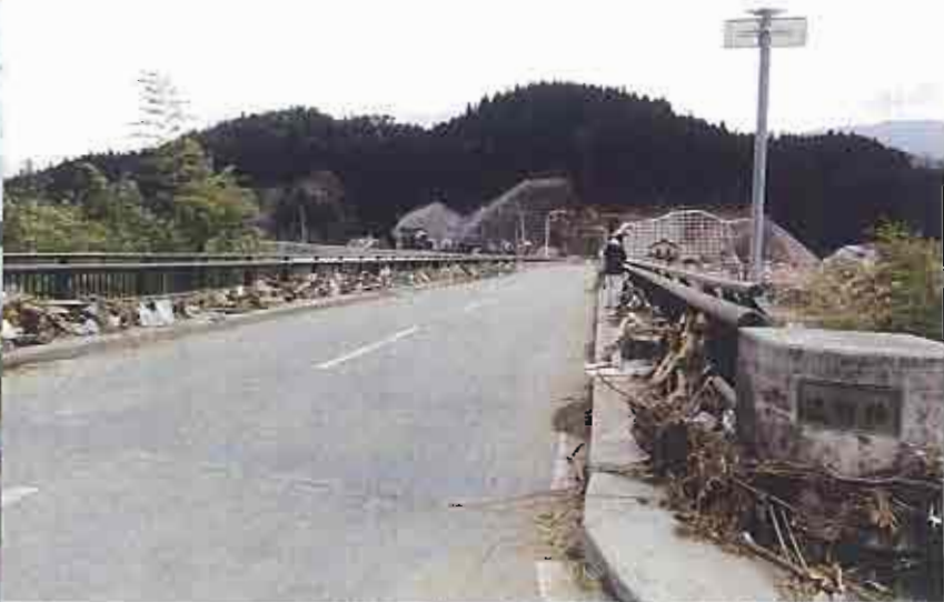
かるうじて残り、復旧・復興の要となった廻館橋（竹駒町）
