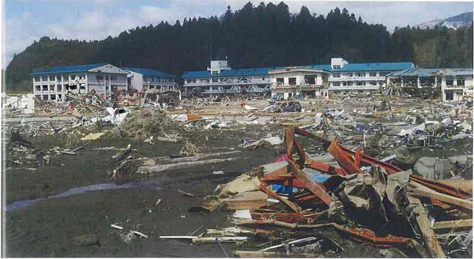
津波が校舎3階まで押し寄せ、全壊した県立高田高校
