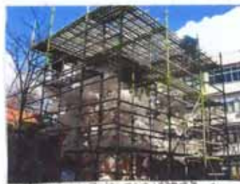
2004年1月24日 温室の建設が始まる。
