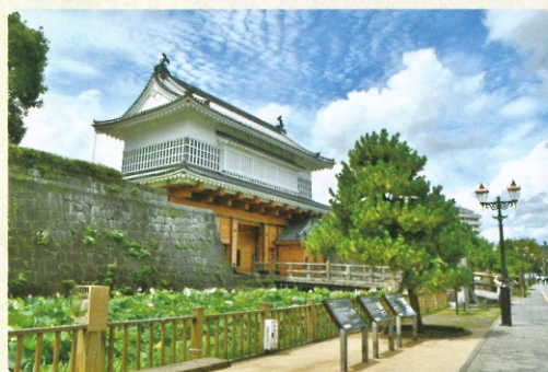
▲約150年ぶりに再現された国内最大の城門「鶴丸城御楼門」。
