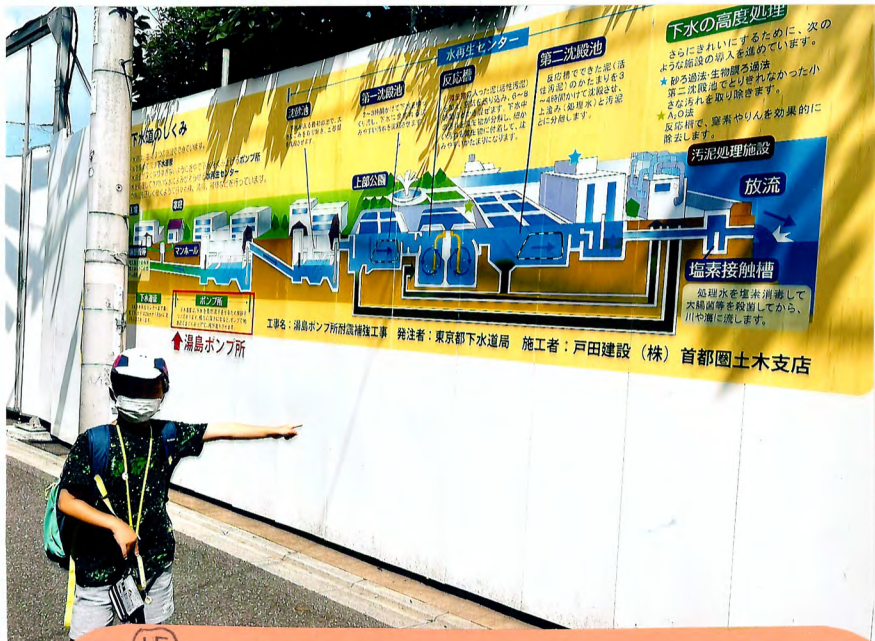
⑮ 水再生センターのせつめいが! 湯島ポンプ所は工事中でした。
